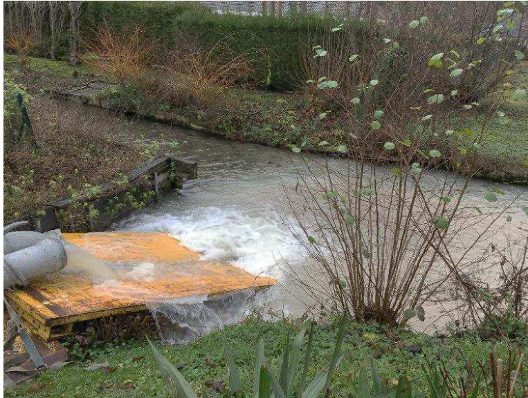
Figure 6 : Exemple d'un dispositif anti-affouillement au point de rejet
